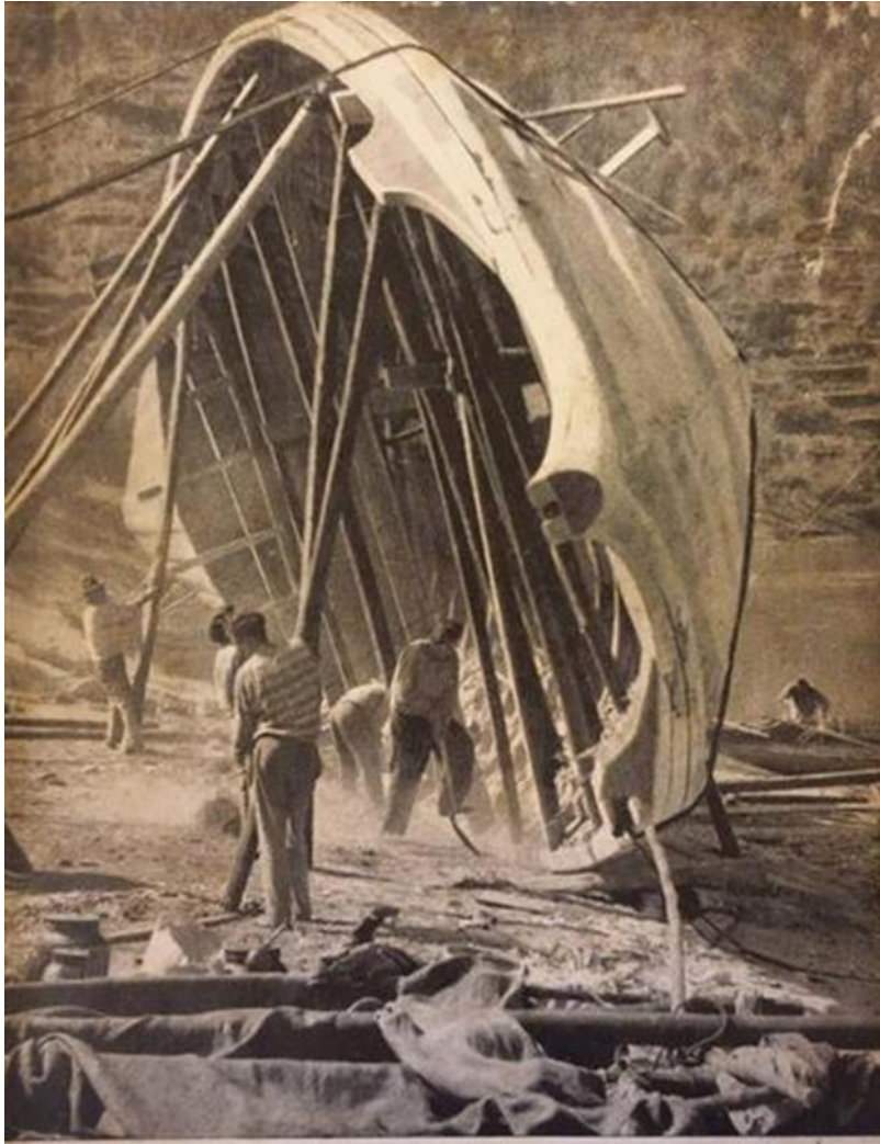
Figura 69 - Rabão em construção
